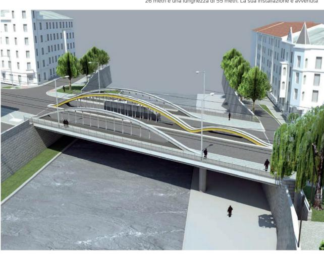
in due momenti diversi per evitare l'interruzione del traffico, una carreggiata per volta: prima è stata demolita una via del ponte esistente, poi le nuove strutture assemblate a terra e infine lanciate nella posizione finale con l'ausilio di un naso
